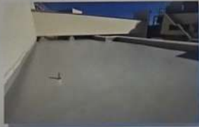
屋上防水工事
