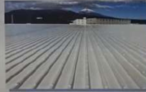
屋根遮熱塗装工事
