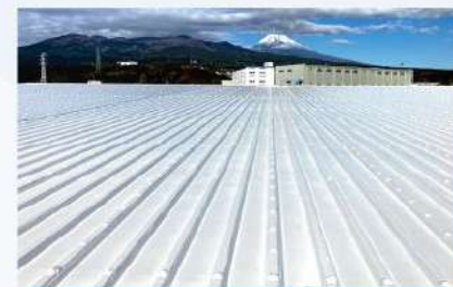
屋根遮熱塗装工事
