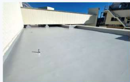
屋上防水工事
